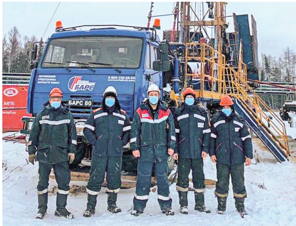
Бригада ТКРС на Куюмбинском лицензионном участке
